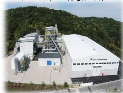
松江バイオマス発電株式会社
