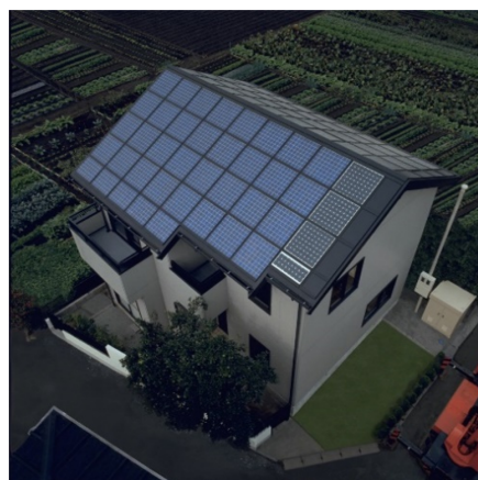
図 1-4 国内初の建材型太陽光発電住宅（1993 年）
