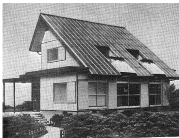
図 1-2 国内初のソーラーハウス（太陽熱暖房給湯住宅）（1976 年）
