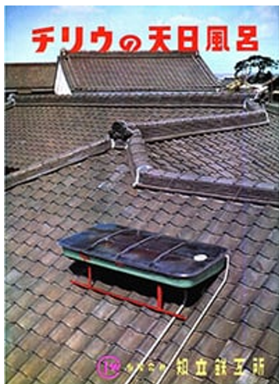
図 1-1 国内初の量産型太陽熱温水器（1957 年）
