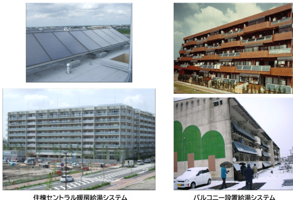
図8 集合住宅の太陽熱利用システムの導入事例 提供：ソーラーシステム振興協会
