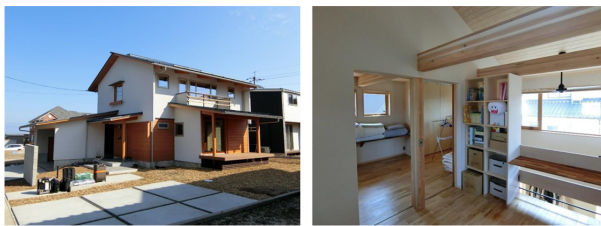
図17 太陽熱・排熱利用暖冷房換気給湯システム（OMX）の導入事例 提供：OMソーラー
