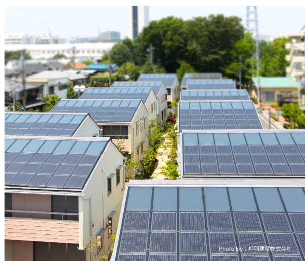
図14 太陽光発電・空気集熱式太陽熱暖房・給湯システム（OMクワトロソーラーシステム）の導入事例
