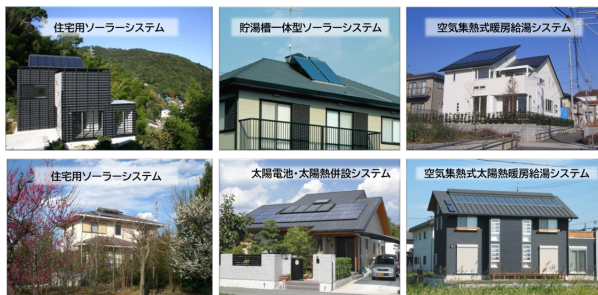
図7 戸建住宅の太陽熱利用システムの導入事例 提供：ソーラーシステム振興協会
