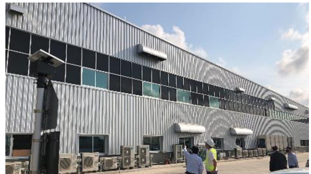
図3 KUBOTA Precision Machinery (タイ) の工場の壁部へ導入した T-GMS ソリッド (サッシ枠に通常のガラスと併用した実装形態。環境省「コ・イノベーション」による脱炭素技術創出・普及事業) により設置。)
