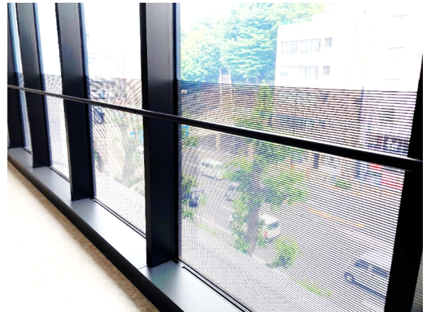
図2 開成学園高等学校校舎廊下部分の窓に導入したT-GMS シースルー (ガラスの下部にシースルー太陽電池のストリングセルを配置。)
