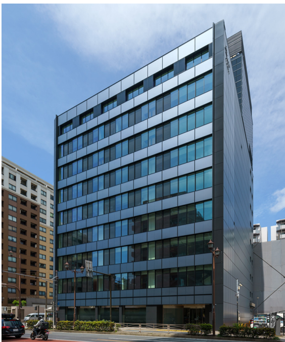
図8 T-GMSを導入した大成建設横浜支店ビル
