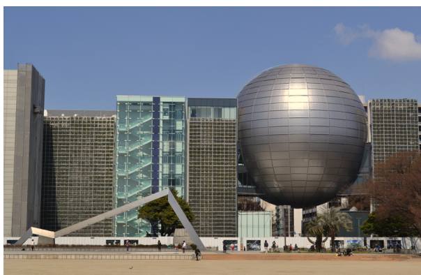
写真 2 壁面 BIPV の事例
