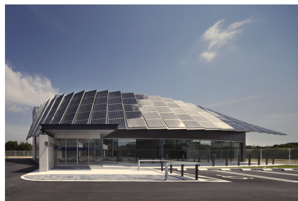
写真1 屋根面設置BIPVの事例 掲載写真撮影：フォワードストローク
