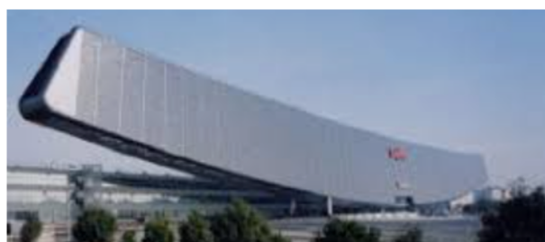
図 1 初期の壁面設置型 BIPV （上図：シースルー窓型、1993 年、三洋電機 1) 下図：大規模壁面型、2001 年、三洋電機）
