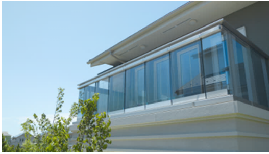
図3 Fujisawa SST（神奈川県藤沢市）のモデルハウスのバルコニーに設置された、ガラス建材一体型のペロブスカイト太陽電池モジュール（出典：パナソニックホールディングス株式会社）
