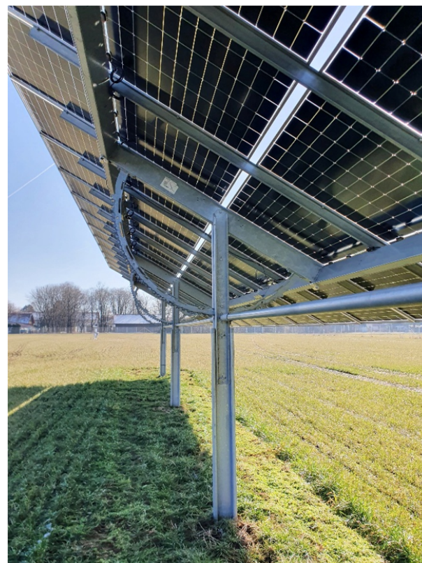
図 4-2：一軸追尾式の営農型太陽光モジュール (著者撮影)
