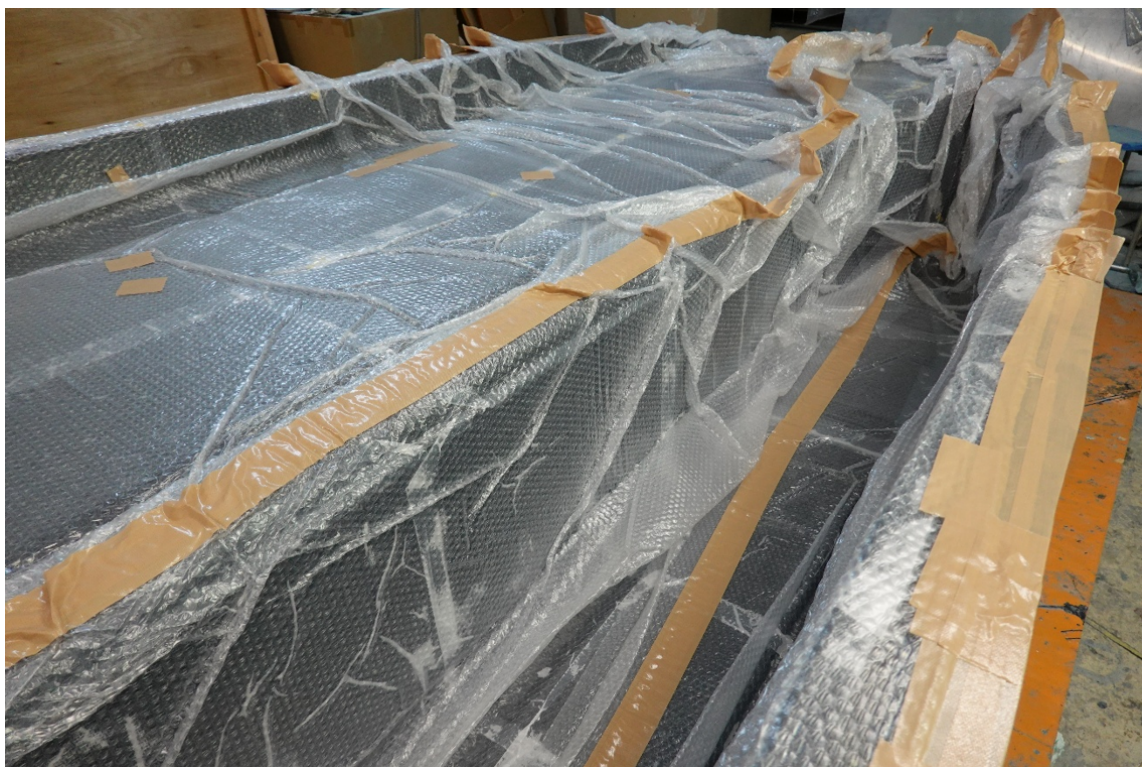
図5 エア抜きに利用するプチプチシート
