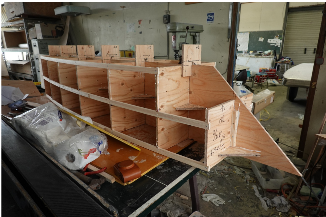
図3 木材による捨て型枠の骨組み
