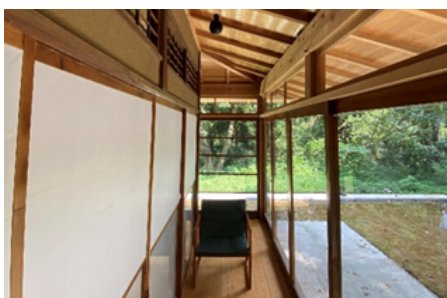
図2 腐朽家屋（上）の外周を太陽熱循環換気を有する広縁（下）として再生した研究対象
