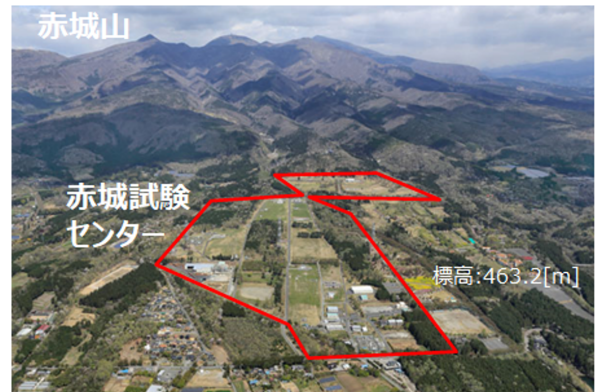
図 8 PV 設置場所 (赤城試験センター) の地理
