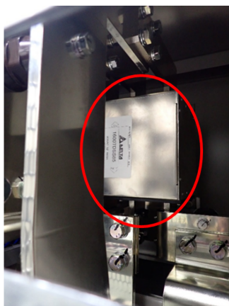
写真3 PCS内部ノイズフィルタの設置状況
