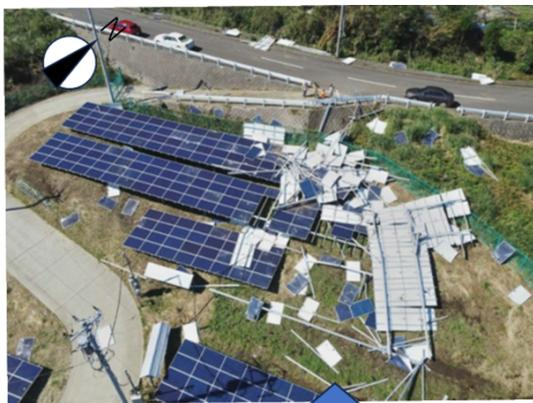
図6 強風被害があった傾斜地 PV 発電所
