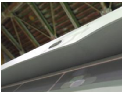
ii. アルミフレーム変形位置拡大（i. の破線位置）
