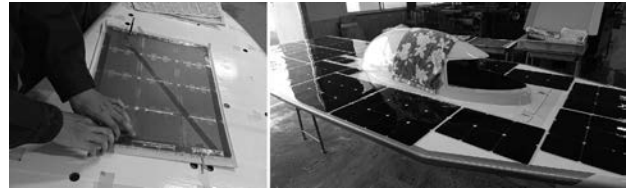
図21 車体への貼り付け作業
