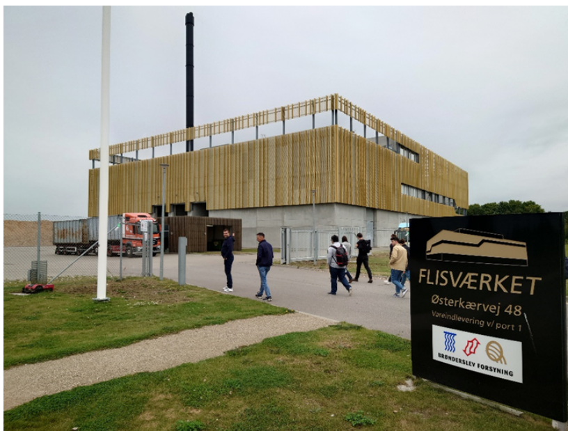
図2 ブロンダースレブ (Brønderslev) 市の地域熱供給会社のプラント
