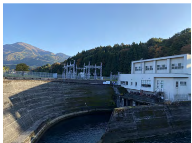
図6 富田水力発電所外観（内部の撮影NGであったため外観のみ）
