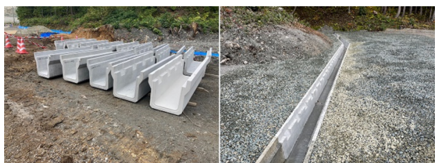
図 10 人工石灰石のコンクリートへの適用例
