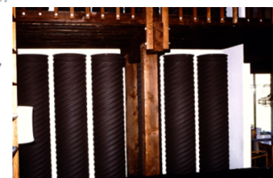
図4 Colbett 邸の配水管を利用した蓄熱体
