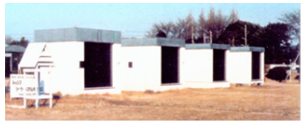
図27 ダイレクトゲインシステム実験棟 右からA棟～D棟。神奈川県厚木市に建てられた。室内全面が黒色つや消し塗料のため窓が黒く見える。
