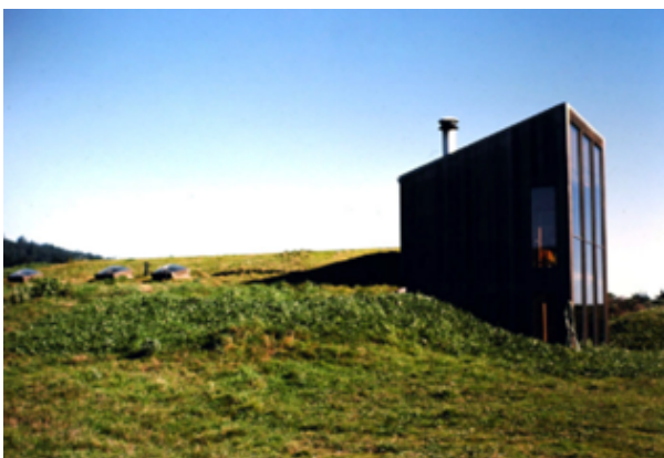
図 11 Sundown House 北側外観
