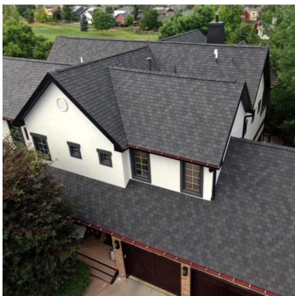
図3 次世代軽量高耐久屋根材を葺いた家屋の例
