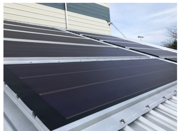
図2 荷重制限屋根への軽量太陽電池施工例
