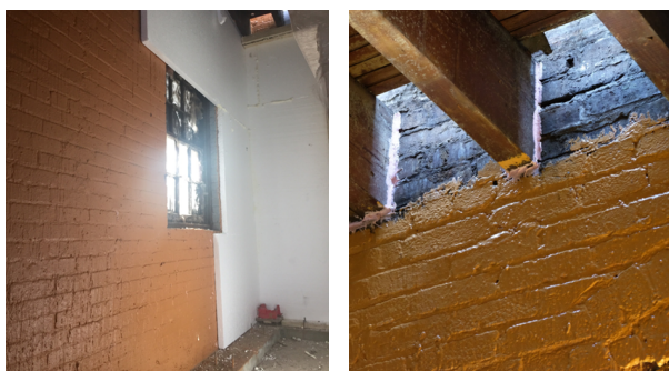
写真9 レンガ壁内表面での防水・気密・断熱
