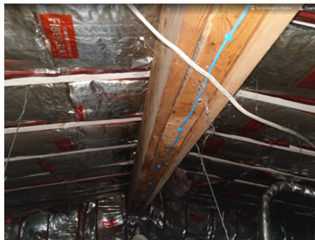
写真2 既存の屋根断熱
