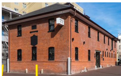
写真8 レトロフィット後の建物
