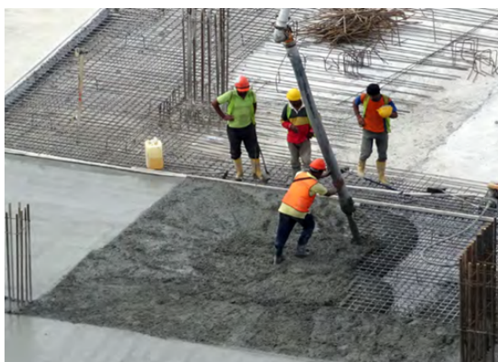
図6 CarbonCure社のCO 2 セメント 出典：CarbonCure Technologies Inc. 15)
