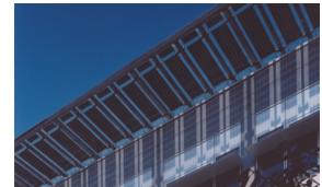
庇一体型の太陽電池
