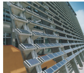
糸満市庁舎の太陽電池ルーバー
