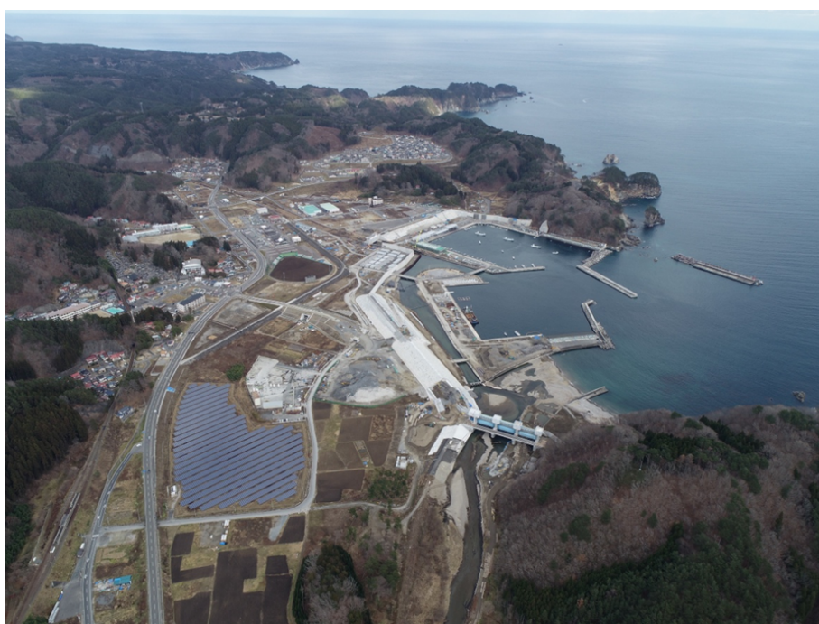
図2 田老太陽光発電所の全景
