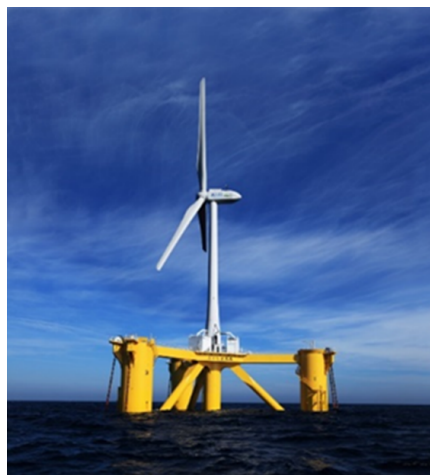
図5 2MW 風車と浮体 (ふくしま未来)
