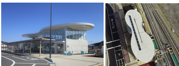
写真2 観光交流施設の屋根への太陽光発電設備の設置(大槌町)
