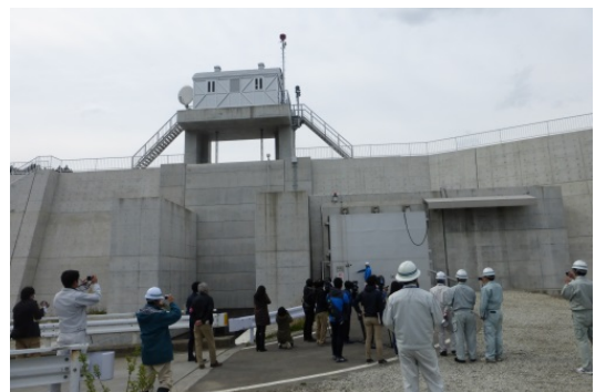
写真1 自動閉鎖システムを整備した防潮堤の陸閘 （大船渡市 合足（あつたり）海岸）
