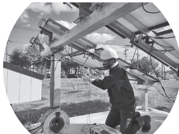
図2 屋外作業:電気安全保護を確保して、太陽電池モジュールストリングの絶縁抵抗測定実験の準備をしているところ
