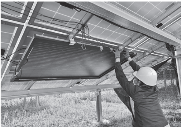
図3 屋外作業：アレイ裏面に照射される日射を計測するための太陽電池モジュールを取り付けているところ
