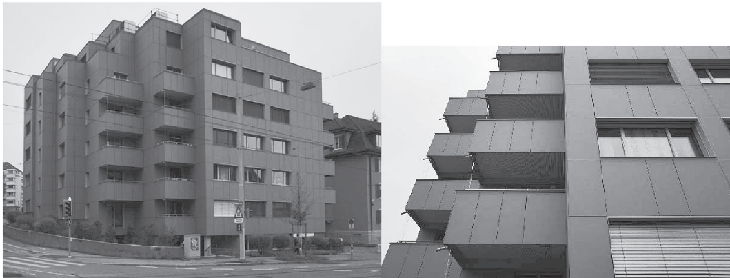
図6 スイス・チューリッヒのアパートのファサードに結晶シリコン太陽電池モジュールを用いたBIPV事例。太陽電池モジュールは2010年の建物のリノベーションの際に取り付けられた。
