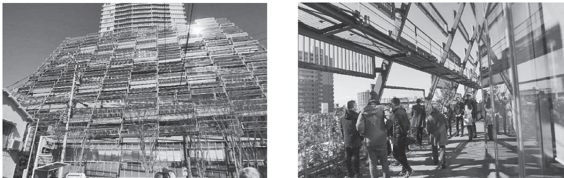
図7 (a) 東京都豊島区役所と高層住宅が統合された建物のBIPV事例と、(b) Task15メンバーによる視察の様子。
