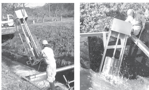
図 12 設置作業風景
