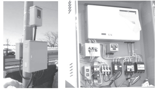
図4 系統連系用設備と盤内部
