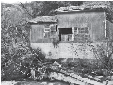
写真4 再生前の須雲川発電所
