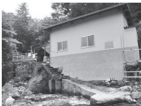
写真5 再生後の須雲川発電所
