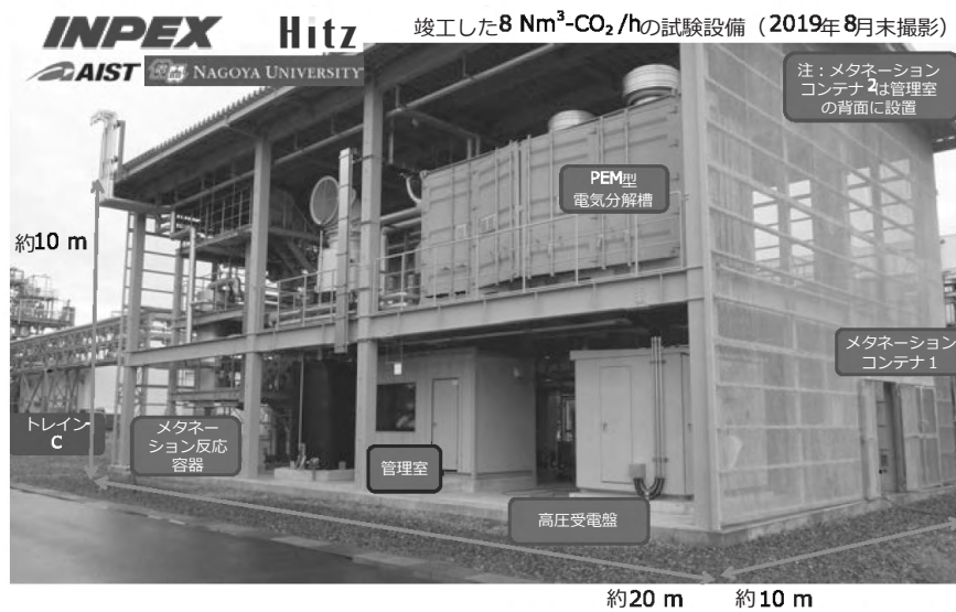
図5 8 Nm 3 -CO 2 /h の試験設備 @INPEX 越路原プラント (Hitz/INPEX)
