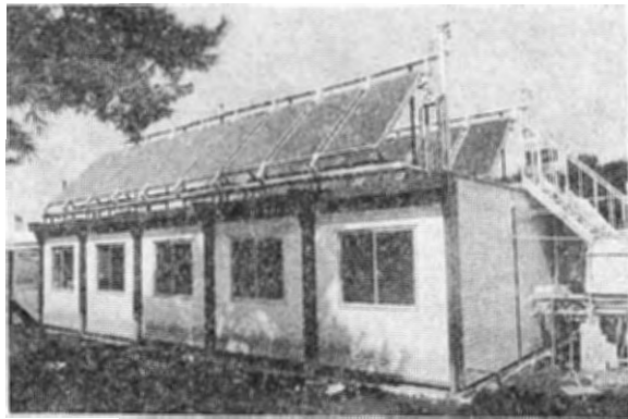
図2 サンシャイン計画土中蓄熱実験システム外観
