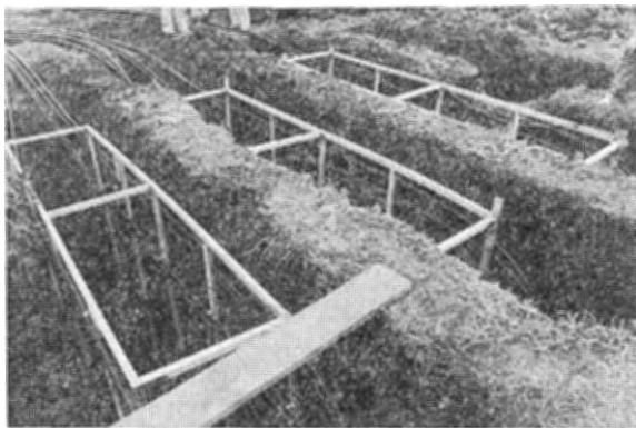
図 8 設置完了した土中蓄熱パイプユニット
