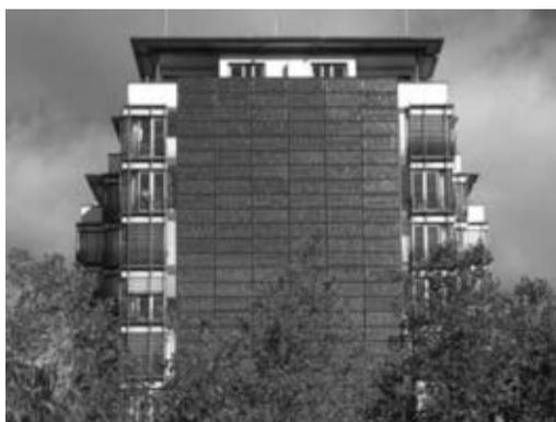
図2 フライブルグの外壁にPVを設置した建物
