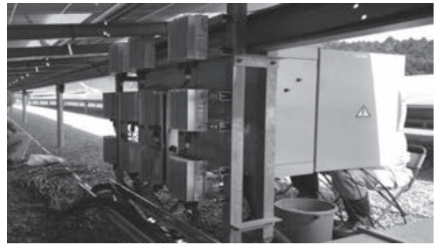
図8 スtring オプティマイザ取り付け方法
