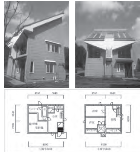
図 4 長岡技術科学大学大の無エネルギー住宅 (写真撮影：H21 年 3 月)
