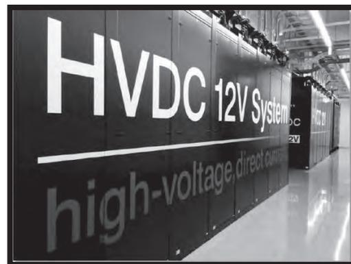
図1 石狩データセンターの直流給電システム
