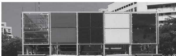
図4 BIPVモジュールの一例（SERIS）左端より透過性、着色モジュール、ブラックモジュール、ホワイトモジュール、描画モジュール。
