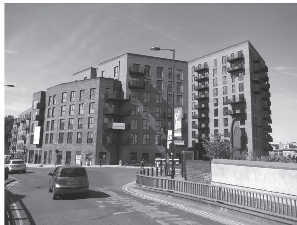
写真3 10階建ての集合住宅(イギリス・ロンドン)
