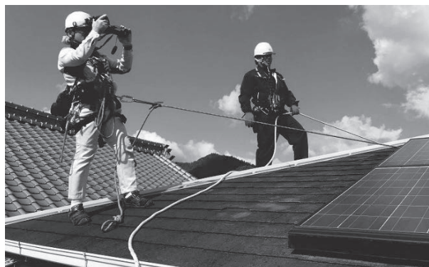
写真 4 屋根上の作業員による点検
