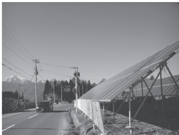
図 4 外部から容易に設備に触れられる PVS の例 (50kW 未満 9 件の分割案件。柵と PVS の間隔がなく横には柵もないため、外部から容易に設備に触れられる)
