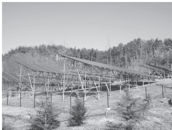
図 5 単管パイプで傾斜地に設置された PVS の例 (50kW 未満 4 件の分割案件。傾斜地をそのままに、架台の単管パイプの長さで調整して設置されている。)
