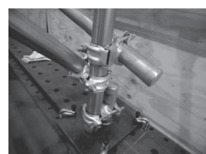
図11 単管クランプによる接合部の例
