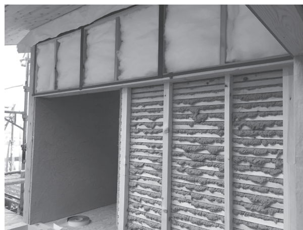
写真12 土塗り後、ポリエステル繊維系断熱材を充填している様子
