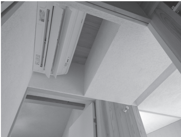
写真5 天井の溝は、区画断熱用断熱ブラインド取り付け箇所
