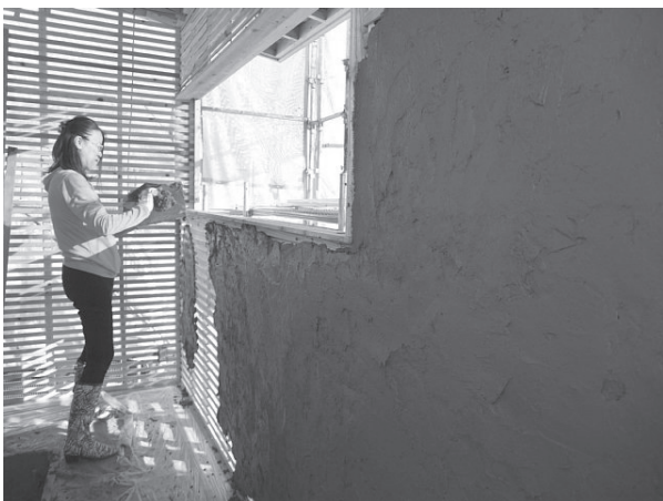
写真6 住まい手自ら寝室の土壁を塗る
