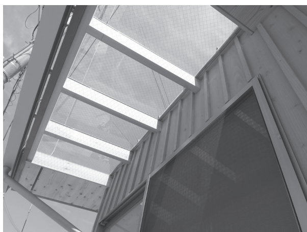
写真9 サンルーム軒先のガラス屋根
