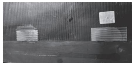
図10 台風の飛散物により穴を開いた2ヵ所を修理した状況
