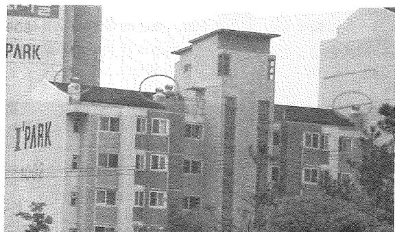
図1 マンション屋根のタービンベンチレーター
