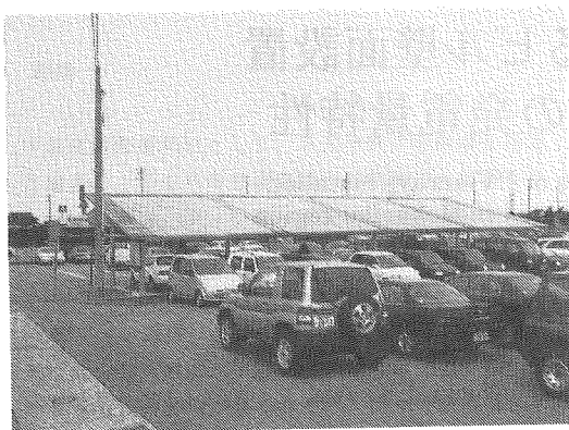
図1 シロウマサイエンス㈱の本社駐車場内に設置された10.3kWp太陽電池アレイの外観図
