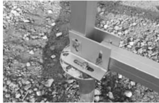
杭頭部のズレ調整金具の例
