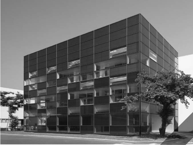
大成建設株式会社 ZEB実証棟(神奈川県横浜市)
