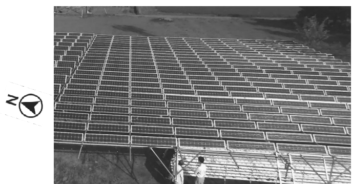
簡易型一軸太陽光自動追尾機構付き 水耕ソーラーシェアリング実験設備
