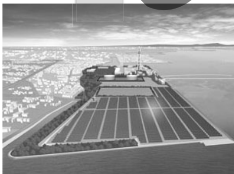
地上の太陽光発電所
