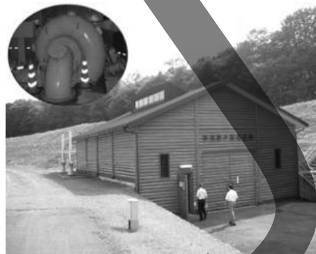
水力発電施設の外観と水車
