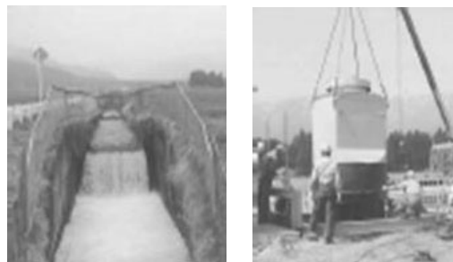
発電機設置前の水路
